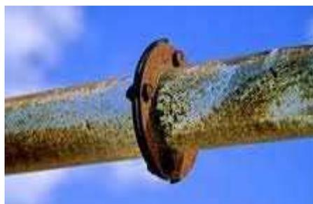
Los materiales constitutivos del circuito hidráulico han de resistir la acción agresiva del agua y del cloro o de cualquier otro desinfectante utilizado, ya que esa acción corrosiva incide negativamente generando sustancias disueltas en el agua que son alimento para las bacterias.
